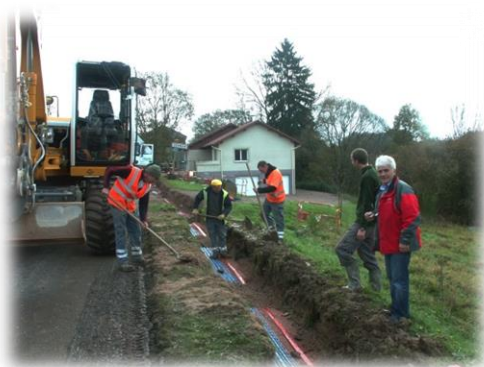
Changement des conduites effectué par le personnel à Uzemain centre à l'occasion de l'enfouissement d'un réseau FDF.
