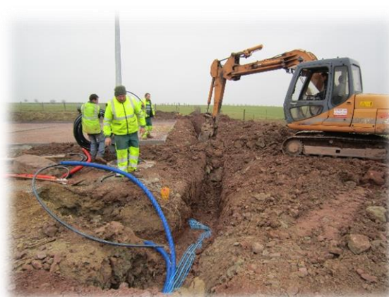
Travaux d'extension à Les Vallois
