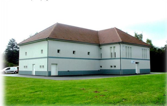
Station de pompage et traitement d'Uzemain
