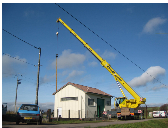
Changement de la pompe du forage
