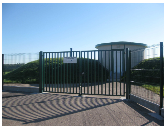
Réservoir de Bonvillet
