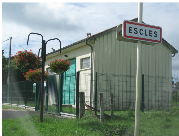
Station de pompage d'Escles
